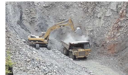
Chargement d'un dumper ▲
