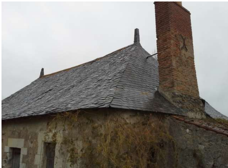
▲ Détail de la toiture
