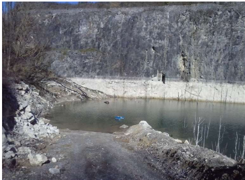
▲ Point de collecte et pompe
