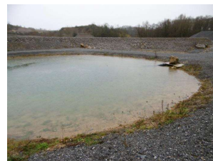
Bassin de décantation
