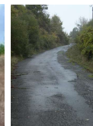
Voie d'accès enrobée
