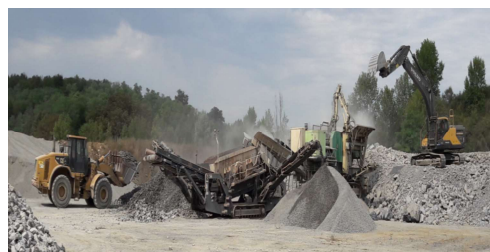
Le traitement des matériaux peut être générateur de poussières. Il sera confiné dans la fosse
