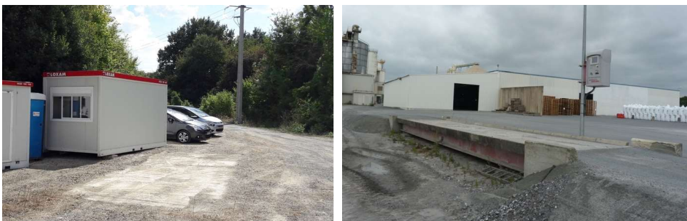
L'ancien emplacement du pont bascule et exemple de pont bascule pouvant être installé à terme.
