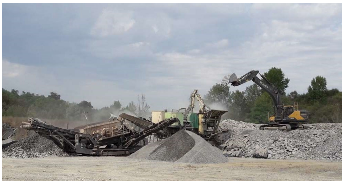
▲ L'alimentation de la trémie d'alimentation par la pelle hydraulique (ici l'installation se trouve sur la plate-forme)
