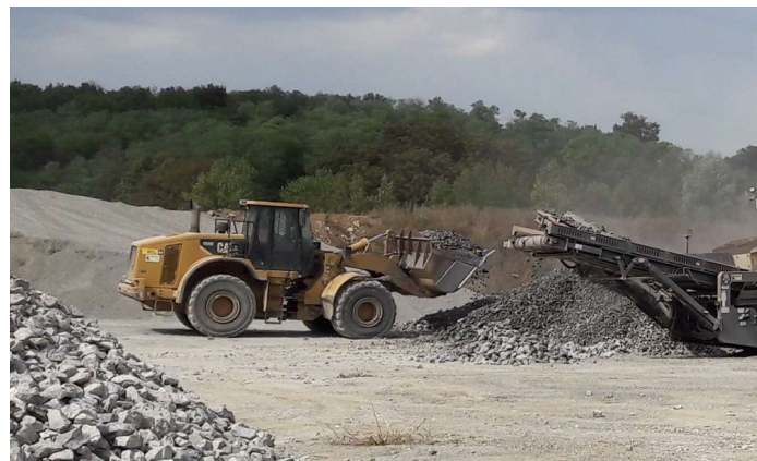
Reprise des matériaux au chargeur pour mise en stock ▲
