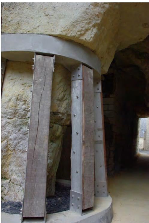
Confortement de piliers à Souzay-Champigny
