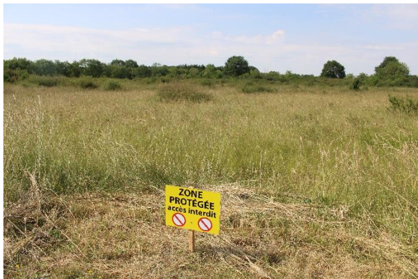
Exemple panneau de restriction d'accès sur zone sensible sur un chantier
