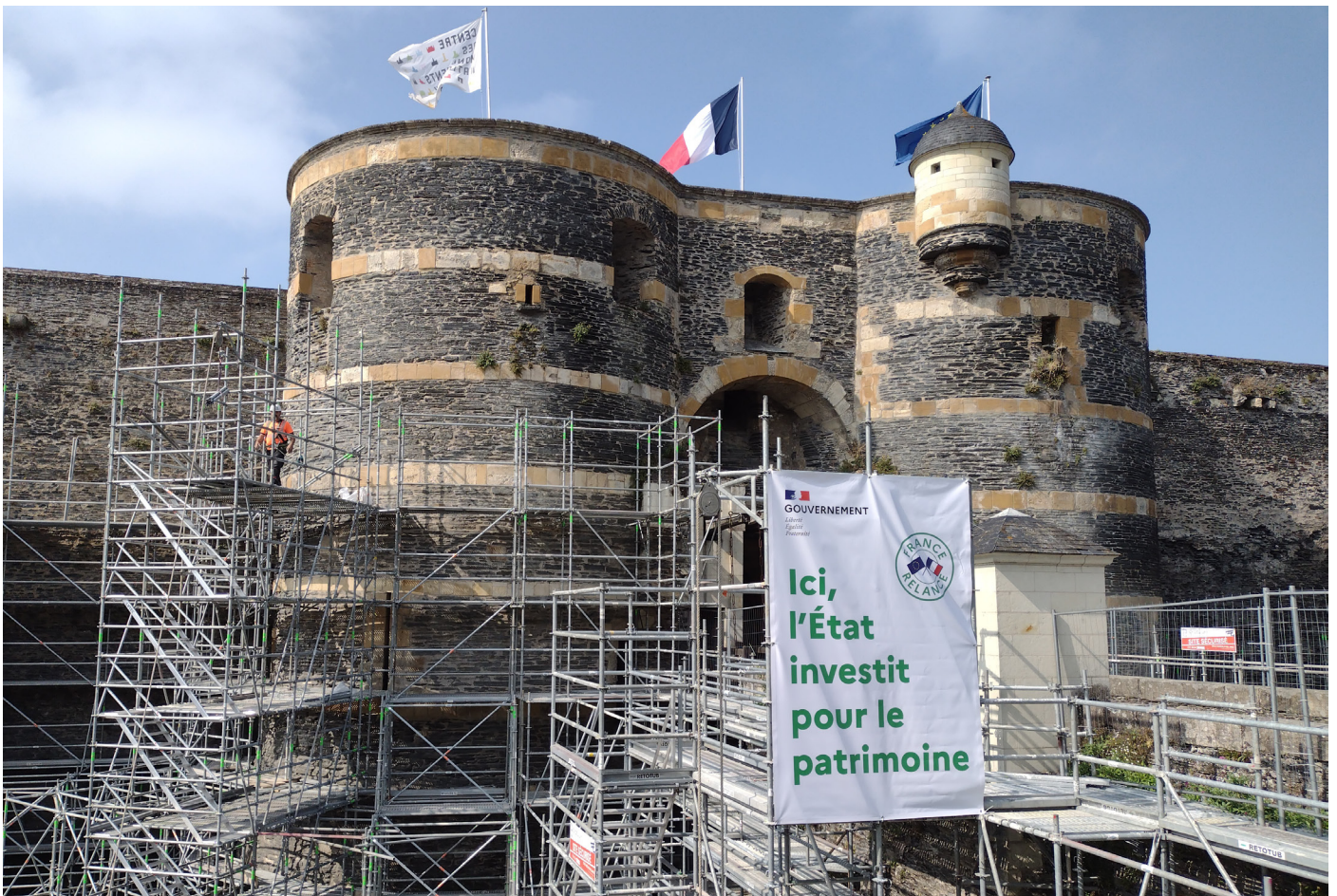
Le Château d'Angers bénéficie, dans le cadre du plan de relance, d'une aide de 6,5 M € pour la restauration du flanc nord, représentant la plus grosse opération de la région en la matière.
