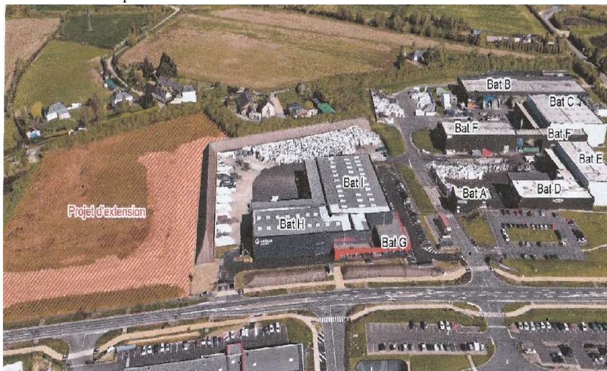
Vue aérienne annotée du site (Dossier, Classeur1, Partie I, Notice de renseignements, p.28)
