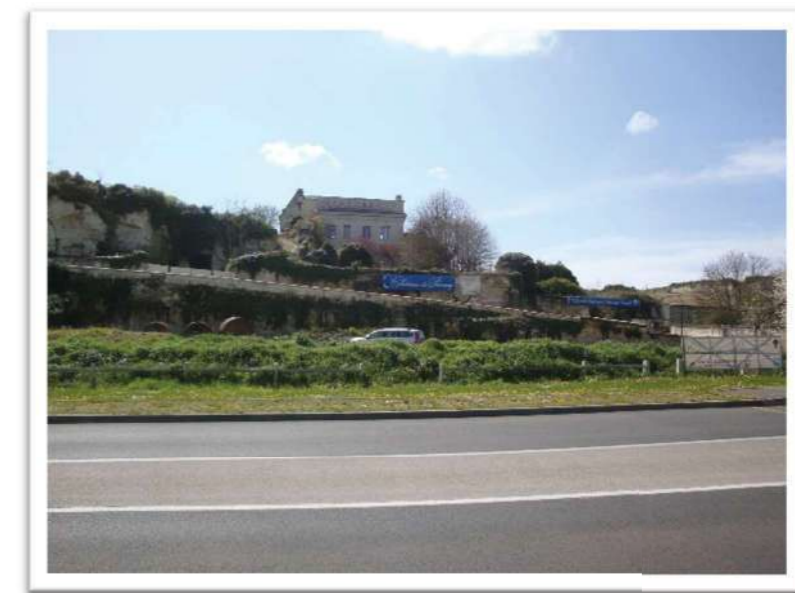
Une levée de terre masque déjà en partie les voitures stationnées. Un muret correctement réglé permettra « d'effacer » le parking.
