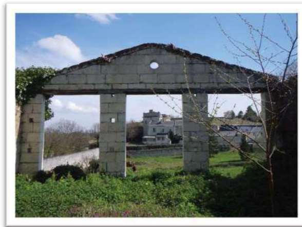
État général des vestiges de l'école de greffage.
