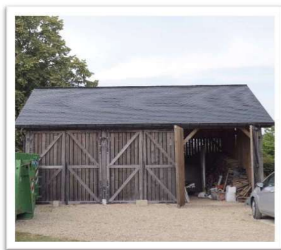
Image de référence : abris bois et couverture en ardoises.
