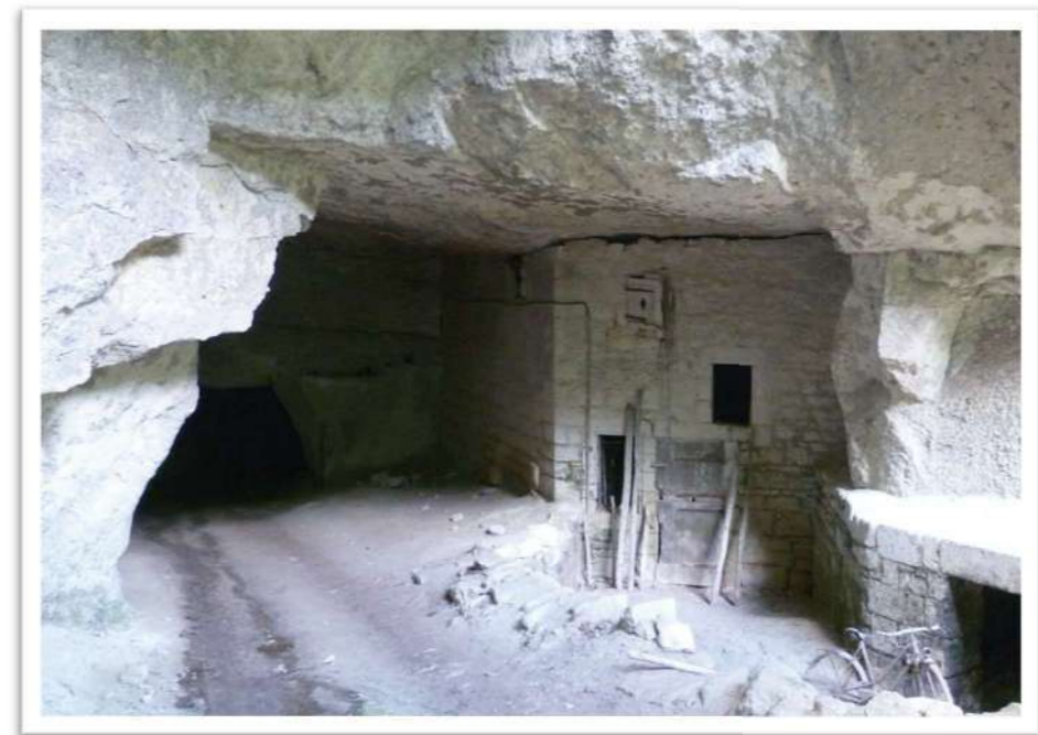
Habitations semi-troglodytiques de coteau, quartier de la Maumènière à Montsoreau
