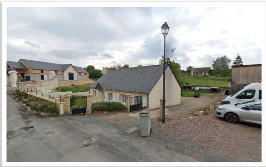
Vue des parkings 3, 4 et 5 depuis la rue Antoine Cristal. Les parkings n°4 & 5 occupent la parcelle construite au centre. L'annexe technique et l'enclos (P5) sont réalisés en bardage vertical, comme sur les deux constructions adjacentes.
