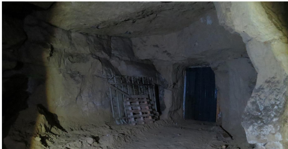
Mise en place de quelques tirants de part et d'autre de la porte d'accès au chai Secteur d'accès vers le chai assez étroit, mais l'accès travaux doit être préservé
