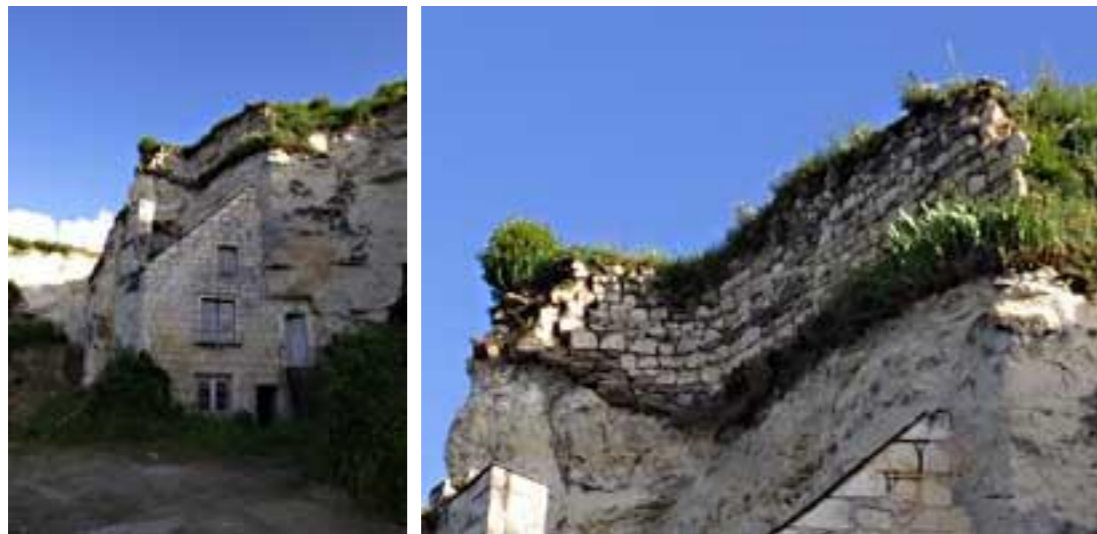
Suppression du mur en moellons sur le nez du coteau
