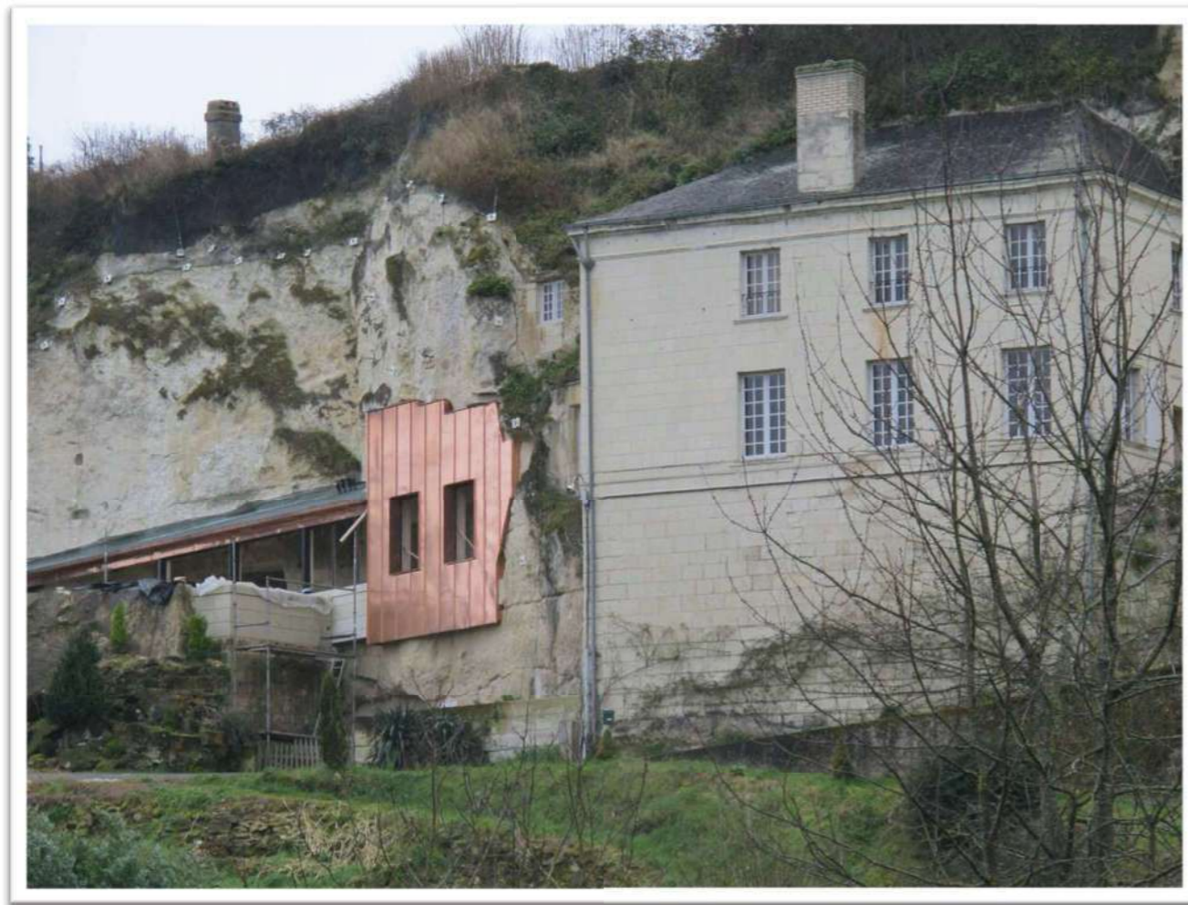
Façade en bardage cuivre d'une extension sur le coteau. Demeure de la Vignole à Turquant.
