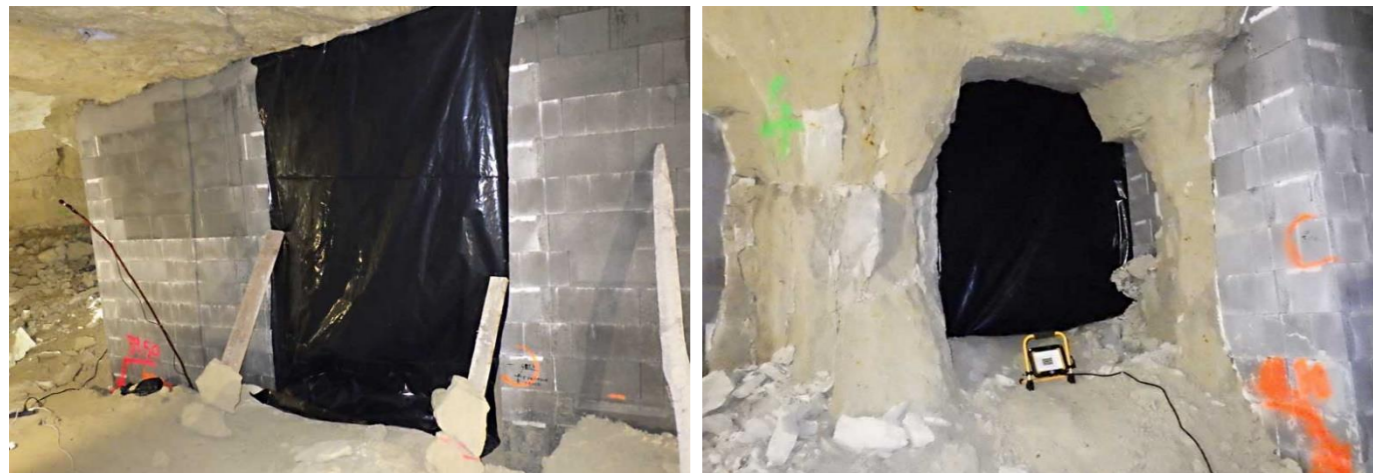
Figure 83 : mise en place de bâches d'obstruction des accès en avant des zones de travaux
