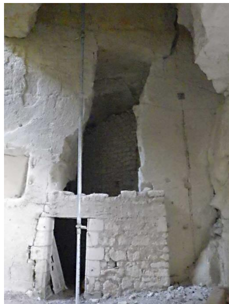
- Mise en place de 1-2 tirants -
