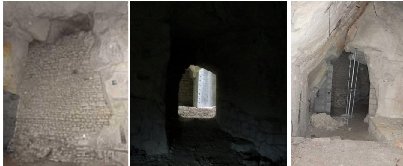
Protection du mur en moellons (conservé dans le projet final) avec pose d'un grillage gabions 60x80 mm sur fils tendus - Pose de 2-5 tirants Sur ce secteur : deux accès de dimensions « réduites »
