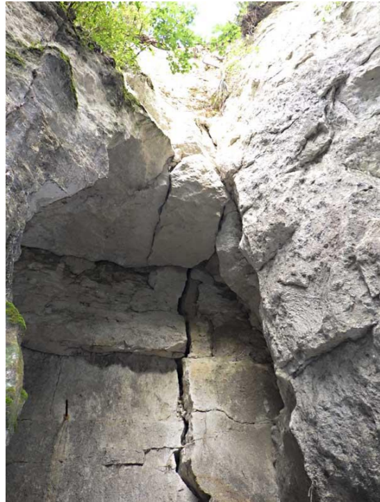
Mise en place de 1 tirant depuis le coteau (sur longrine) Large zone dans un fontis : calfeutrement total impossible
