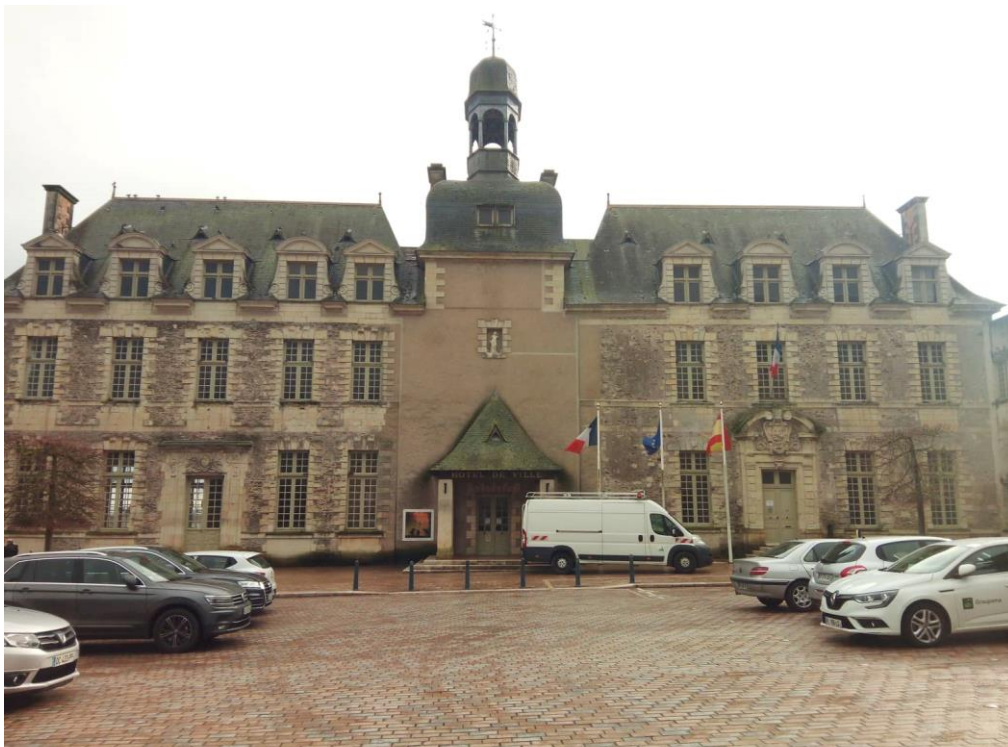
Figure 2 : Façade nord de l'hôtel de ville concernée par les travaux.
