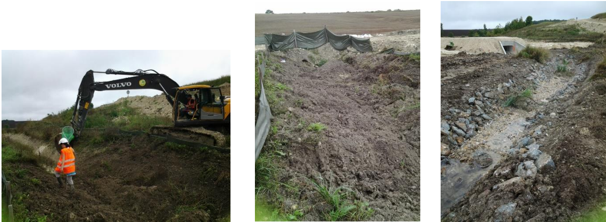
Figure 12 : Photos d'un exemple de griffage de cours d'eau avant destruction – T Hercé
