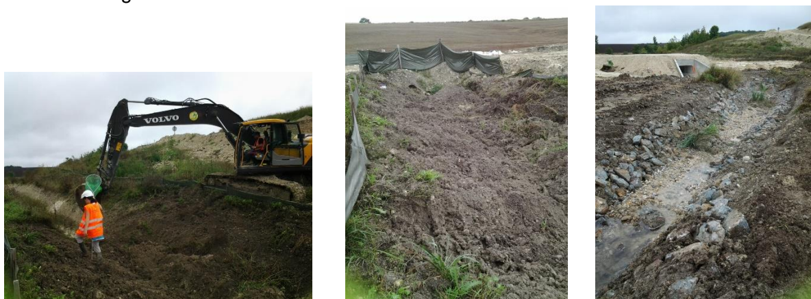
Figure 25 : Photos d'un exemple de griffage de cours d'eau avant destruction et de la réutilisation de la végétation sur le nouveau tracé – T Hercé
