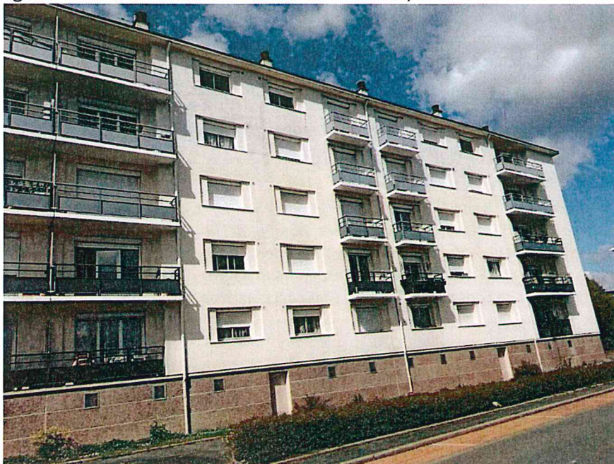
Figure 21 : localisation des sites de nidification, bâtiment Foch-face sud
