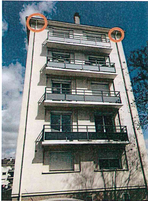
Figure 19 : localisation des sites de nidification, bâtiment Foch-face ouest
