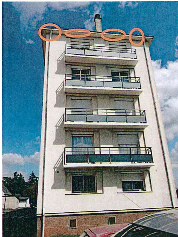
Figure 10 : localisation des sites de nidification, bâtiment De Gaulle-face ouest
