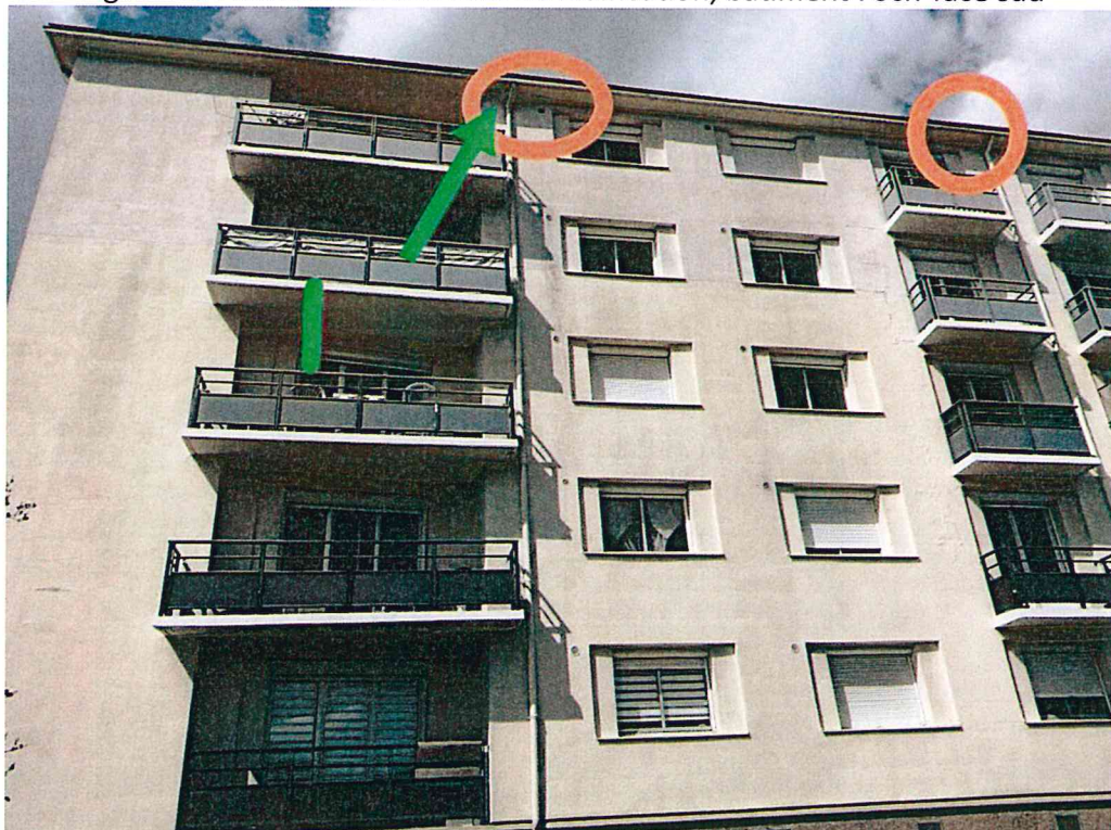
Figure 20 : localisation des sites de nidification, bâtiment Foch-face sud
