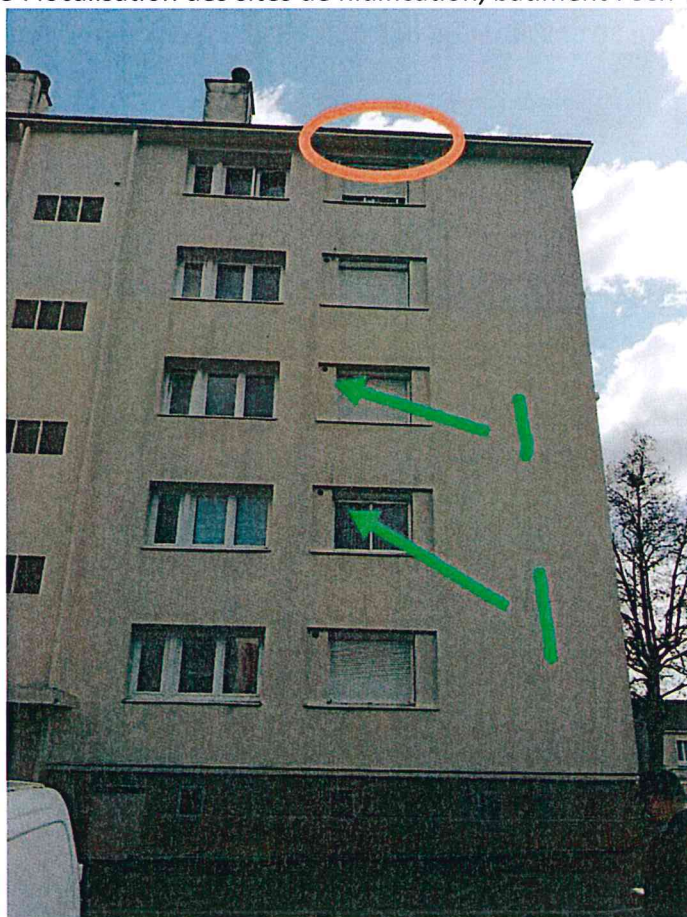
Figure 18 : localisation des sites de nidification, bâtiment Foch-face nord
