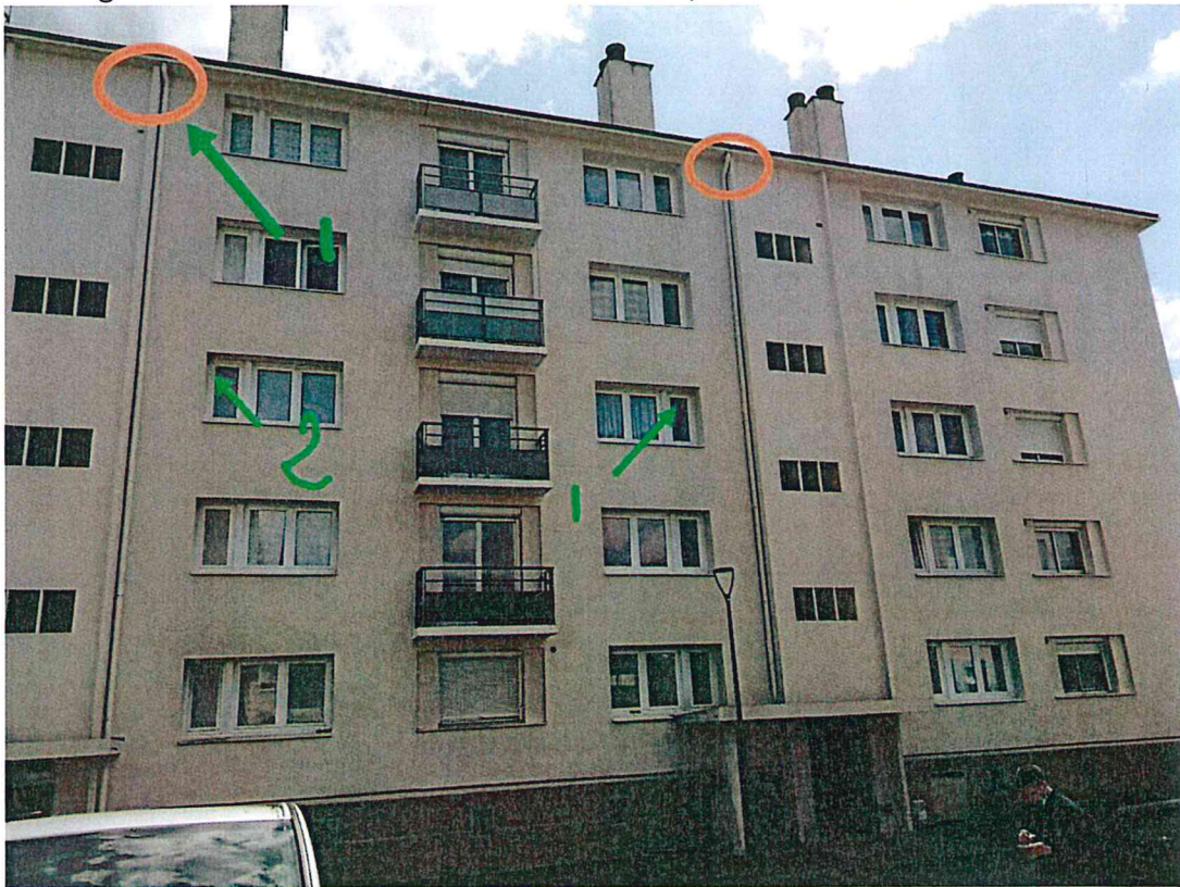
Figure 9 : localisation des sites de nidification, bâtiment De Gaulle-face nord
