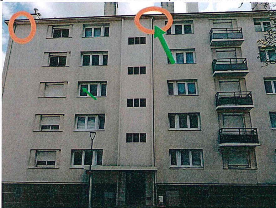
Figure 8 : localisation des sites de nidification, bâtiment De Gaulle-face nord
