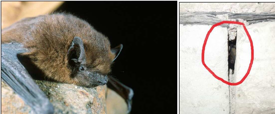
De gauche à droite : La Pipistrelle commune fréquente notamment les fissures en hiver (L.-M. Préau). Site connu d'hibernation : fissures de l'entrée après le pont levis (O. Loir, mars 2020)
