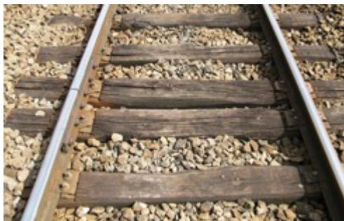
Rails courts sur traverses bois
