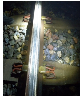
Rail après meulage
