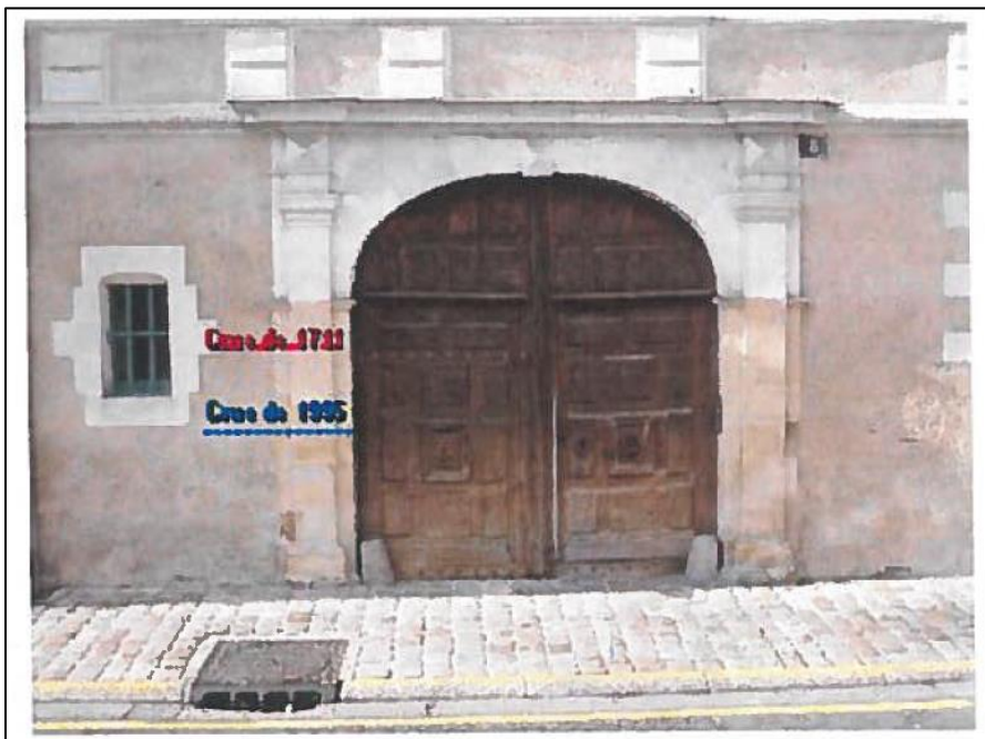
Figure 22. Photographie des hauteurs atteintes par la crue de 1711 (rouge) et par la crue de 1995 (bleu), rue du Cornet à Angers [source : PGRI Loire-Bretagne]
