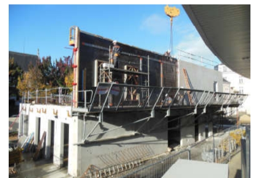
chantier du restaurant universitaire rue Rabelais - Angers
