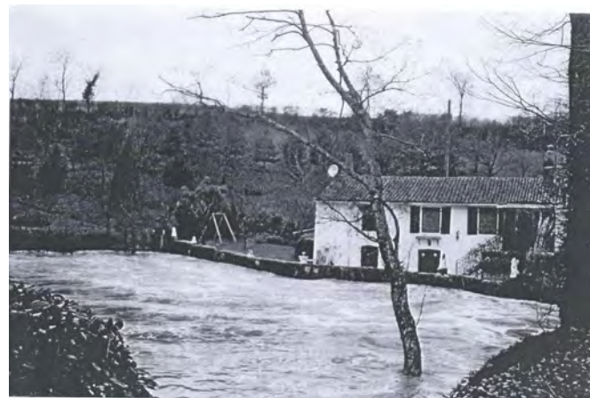
crue 2003 –amont pont D54
